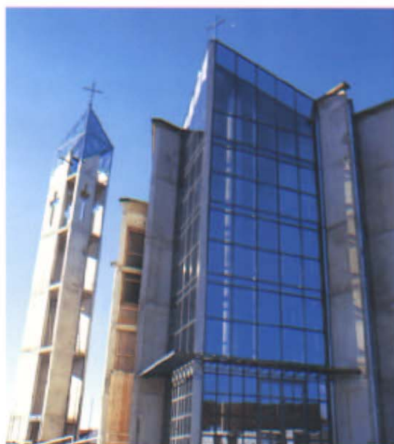
građevina: CRKVA SV. PETRA I PAVLA, (u tijeku) VELIKA GORICA POLUSTRUKTURALNA FASADA m 2 = 300 U FASADI UGRADENI VITRAJI
